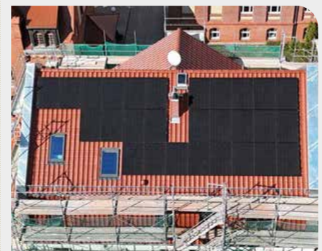
28 Module produzieren hier künftig Strom für fünf 2-Personen-Haushalte
