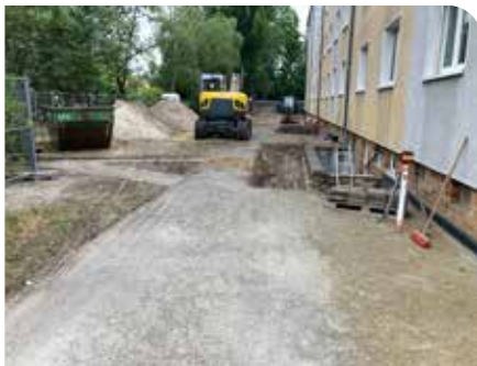
Für den folgenden Balkonanbau werden in der Straße der Jugend Kellerabgänge erneuert und Fundamente gesetzt.
